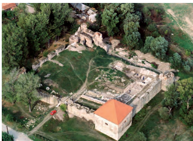
Abb. 7. Die Burg Ónod während der Freilegung von Nordosten (Foto: www.civertan.hu ).
