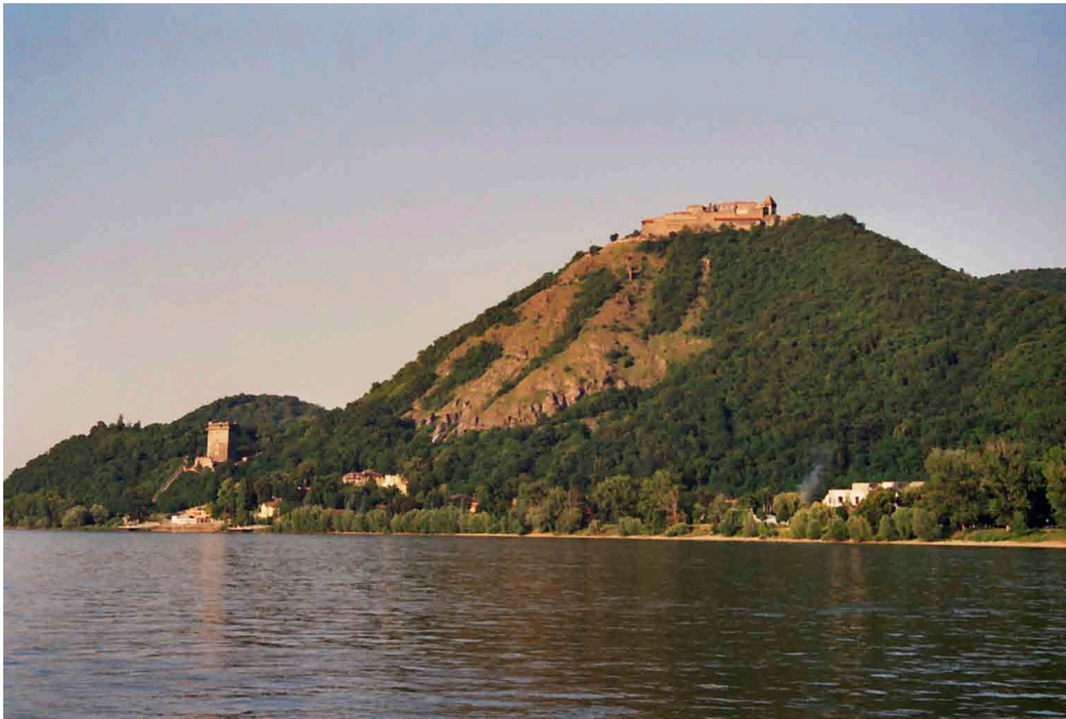
Abb. 1. Gesamtansicht von Visegrád (Obere Burg: oben; Untere Burg: links; Königspalast: rechts) (Foto: Verf.).
