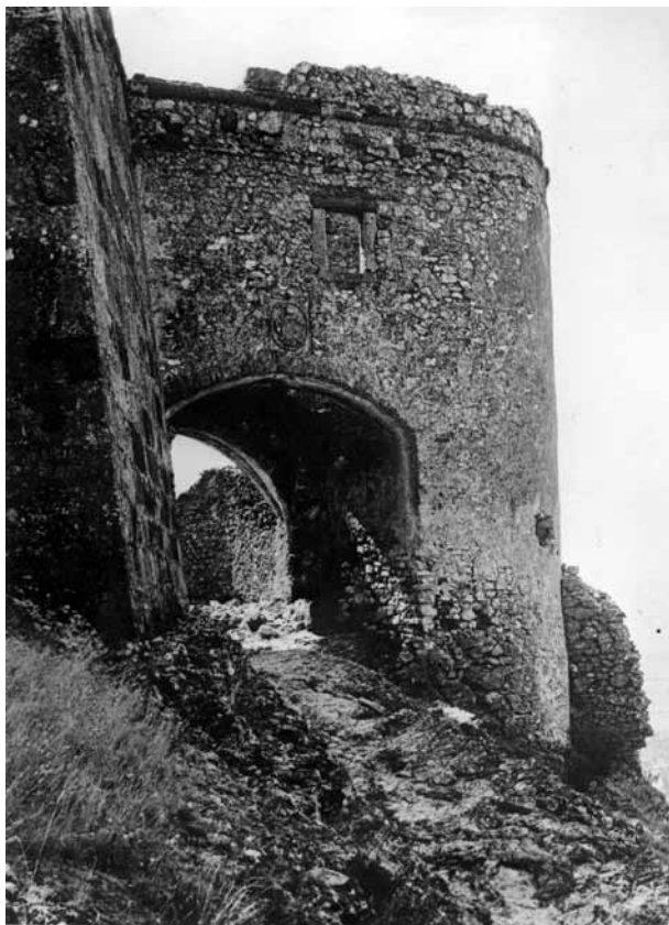
6. A külső kaputorony a helyreállítás előtt
